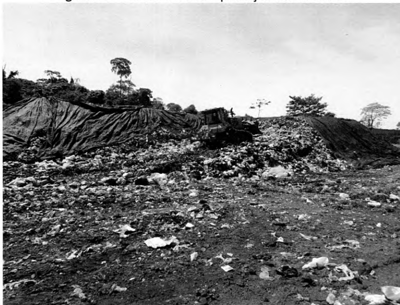
Figura 14 – Trabalho de compactação dos resíduos.
